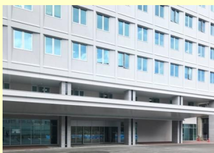
議会庁舎東側が正面玄関
